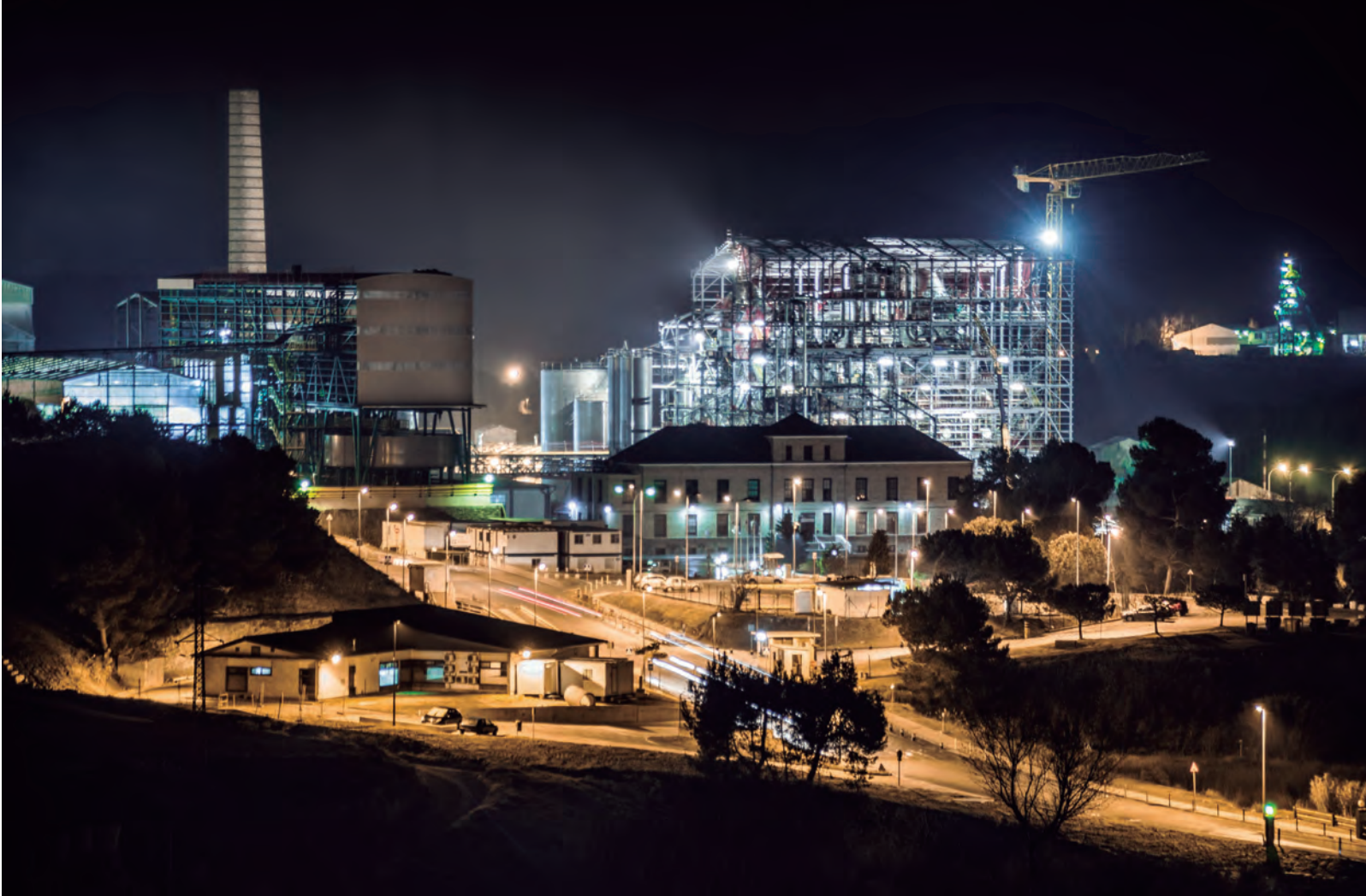
Figura 8. Imatge de la construcció de la nova planta a Súria (Barcelona). Foto ICL Iberia
