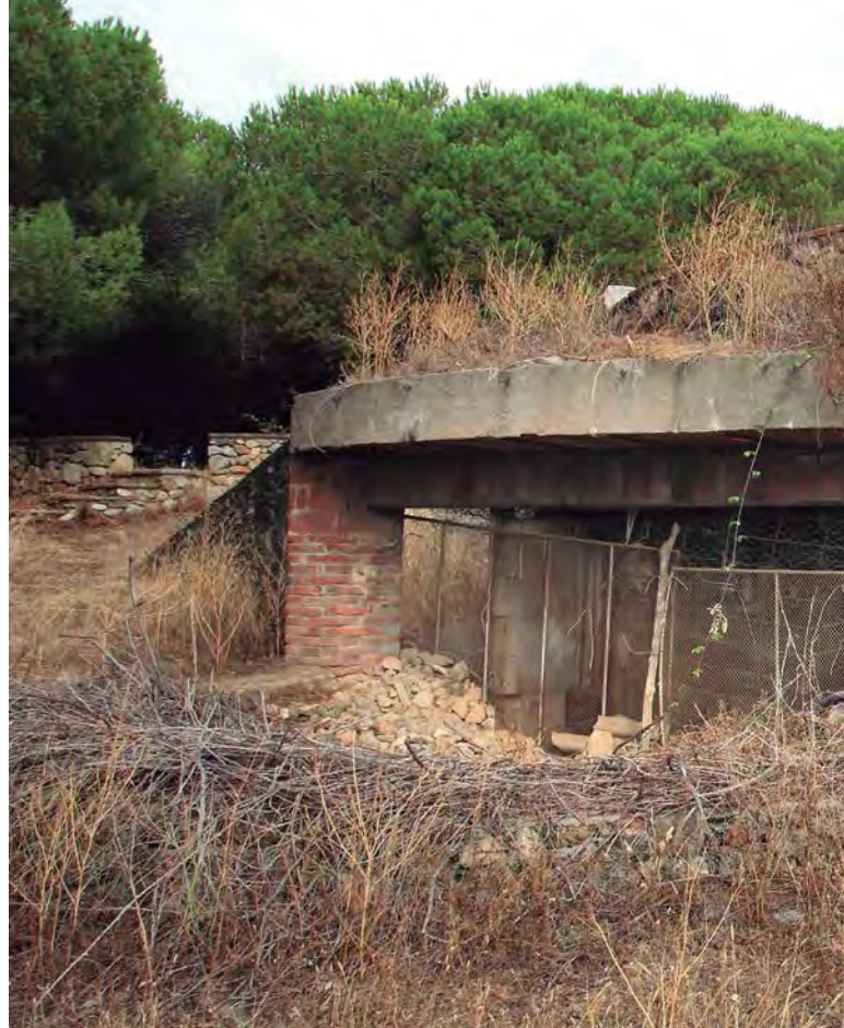
Detall del búnquer de la "Torre dels Encantats". Foto: David Castañeda.
