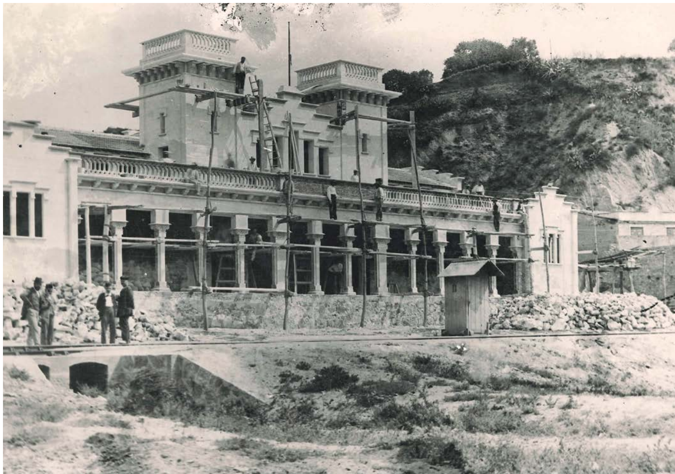
Balneari Lloveras en construcció. 1890-99. Autor desconegut. Arxiu Històric Fidel Fita d'Arenys de Mar.
